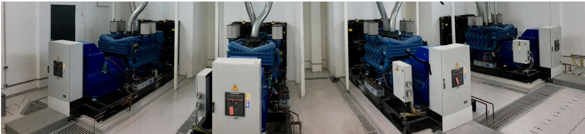
L'avviamento è rilevante quando si scelgono motori per questo tipo di applicazione dove l'affidabilità è fondamentale. GREEN POWER può migliorare l'avviamento standard nei motori incorporando sistemi ridondanti con due motori elettrici con sistemi di batterie indipendenti o la combinazione di un motore elettrico e un altro avviamento pneumatico. Vengono, inoltre, incorporati sistemi che possano facilitare l'avviamento e renderlo più rapido possibile come batterie senza manutenzione e scaldiglie.
